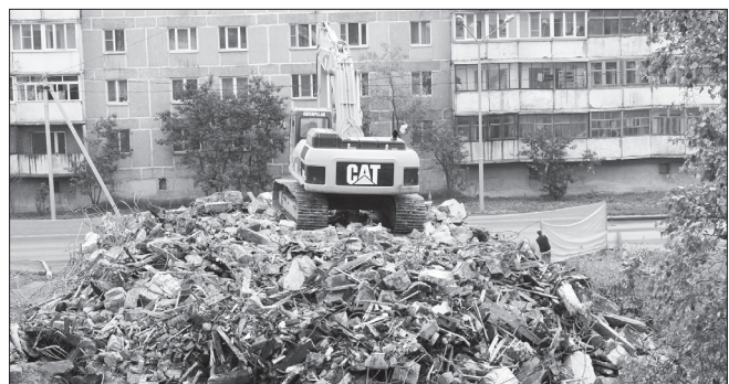
Снесен аварийный дом на улице Гвардейской...
